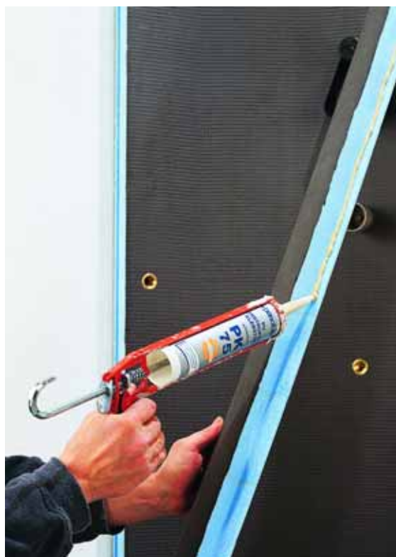
4. Соединительные элементы склеиваются с помощью PU клея.
