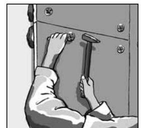
В просверленные отверстия в точках цементирования вбейте дюбели.
